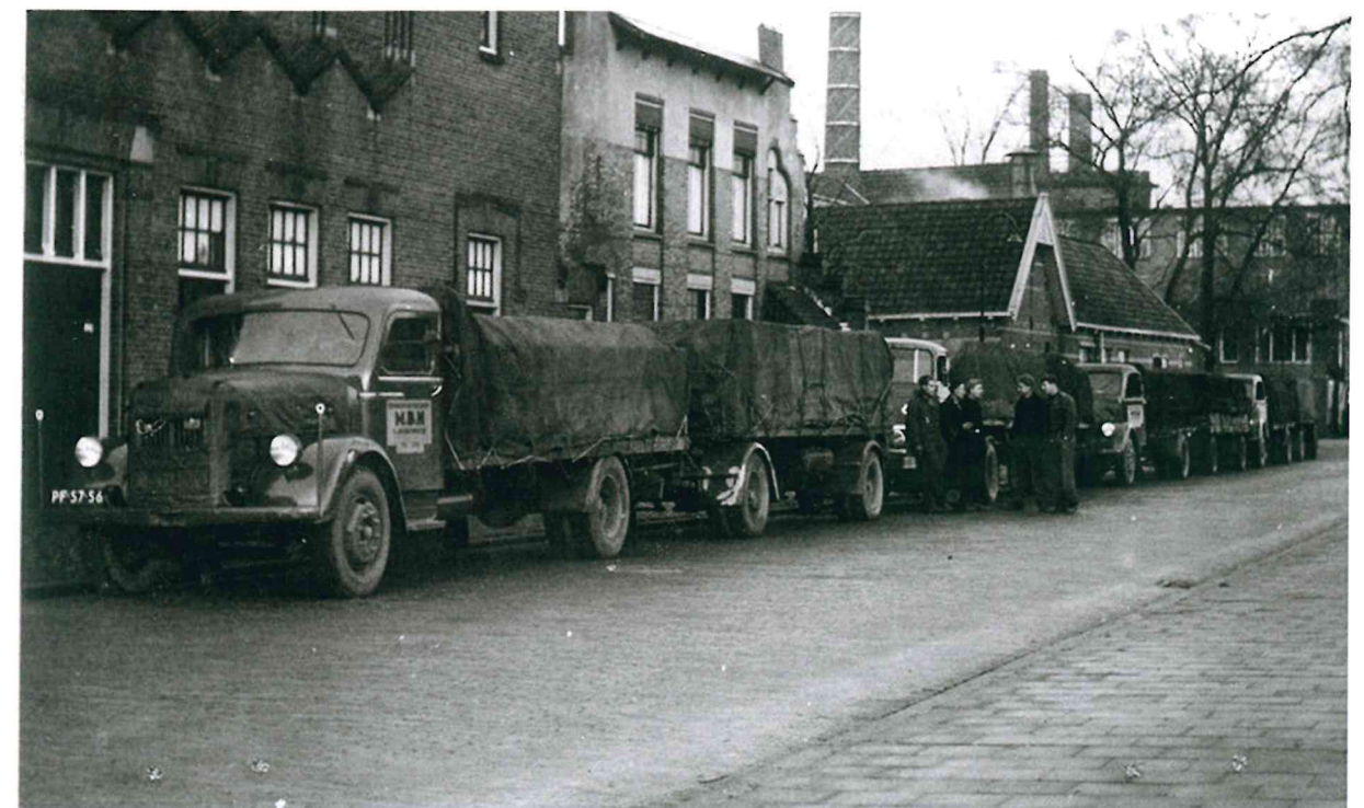
In de winter van 1954 werd de relatie met CCF definitief. Het vervoer naar de havens van Amsterdam en Rotterdam was over het water niet mogelijk en MBN werd ingeschakeld om de producten over de weg naar de havens te brengen
